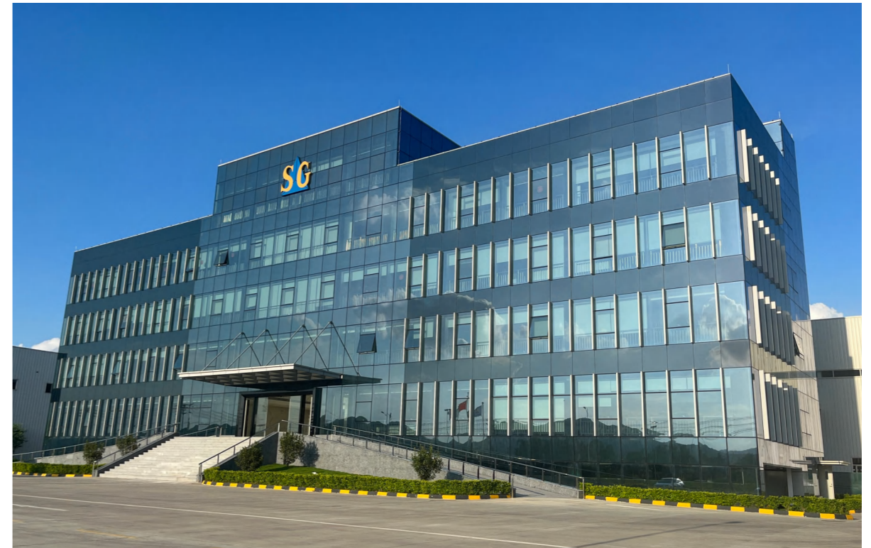
肇庆南玻节能玻璃有限公司办公大楼项目(500m 2 )
