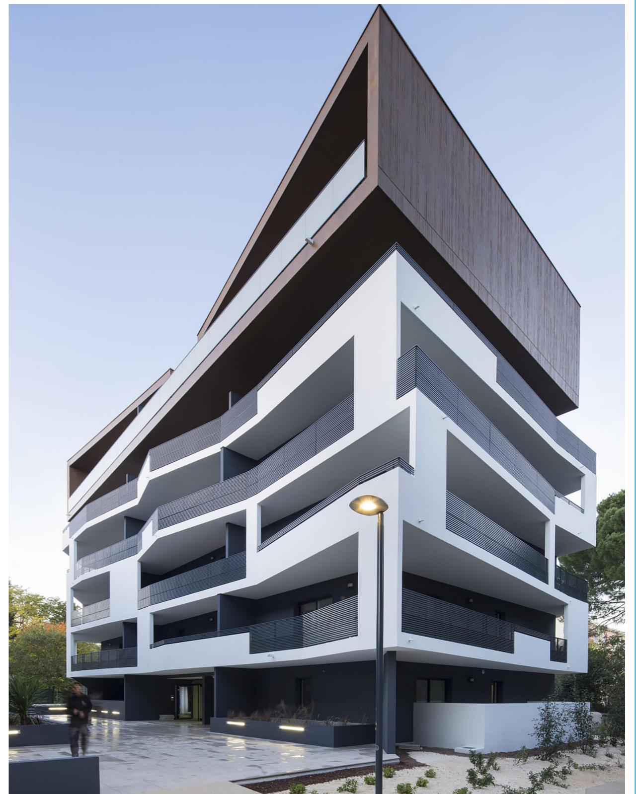
法国蒙彼利埃幕墙BIPV项目 (3600m 2 )
