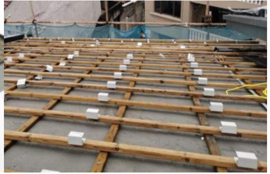
铝合金挂件安装施工图
